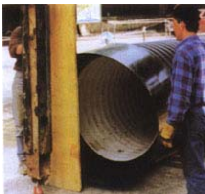
Возможно применение плоского упора для равномерного распределения усилия при монтаже
