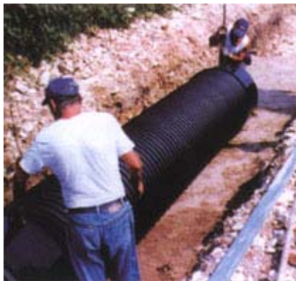
Монтаж трубы диаметром 800 мм в раструб с помощью примитивного рычажного устройства
