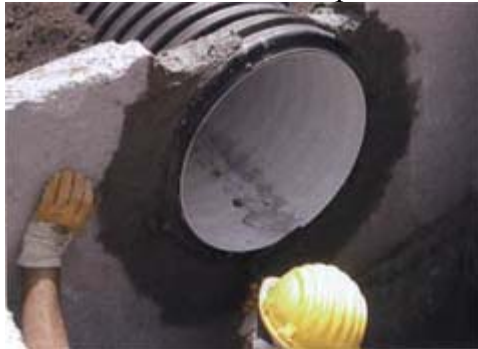
Монтаж трубы КОРСИС в стенку бетонной камеры
