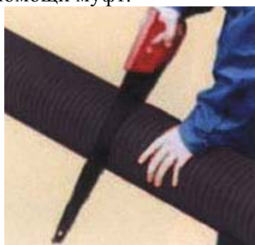
Резка трубы КОРСИС
