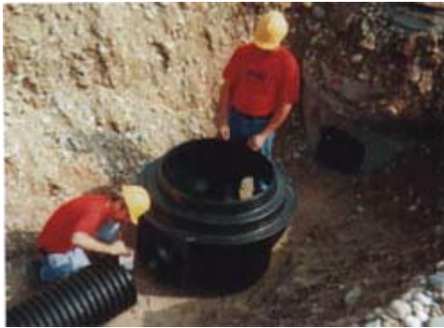
Соединение лотка ПЭ колодца с трубой
